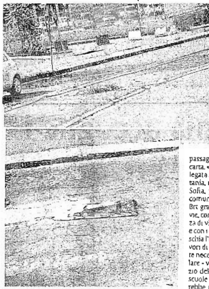
C'ERANO UNA VOLTA I CORDOLI Sopra il grafico che riproduce il tracciato del Brt "Obelisco-Stesicoro", linea veloce molto apprezzata dagli utenti. Nelle foto di Davide Anastasi alcuni tratti delle corsie "protette" con i cordoli danneggiati o addirittura ormai inesistenti
